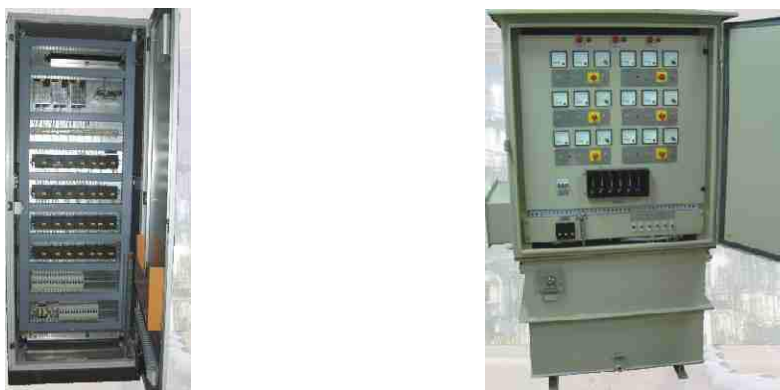
Слика 5: Станице катодне заштите са и без даљинске контроле
